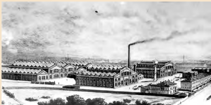
Завод динамо-машин «Сименс-Шуккерт» (будущий завод «Электросила»)
