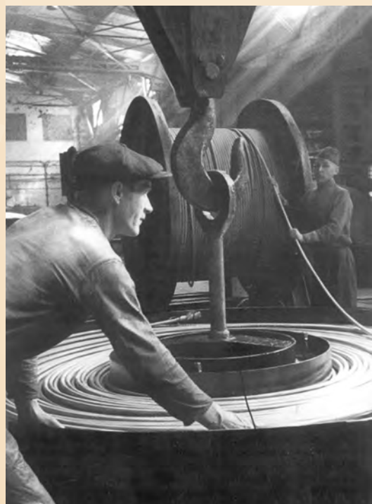
Изготовление высоковольтного кабеля на заводе «Севкабель» в годы войны
