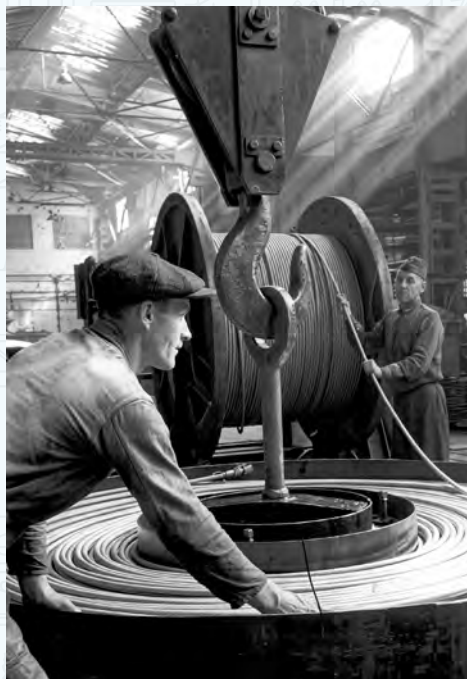
Изготовление высоковольтного кабеля на заводе «Севкабель» в годы войны
